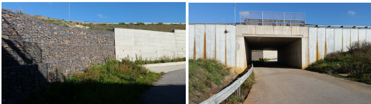
Figura 27: gabbioni e sottopasso sezione 253
