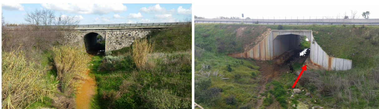
Figura 28: ponti sul Rio Setti; la freccia indica la presenza dell'erosione del manufatto
